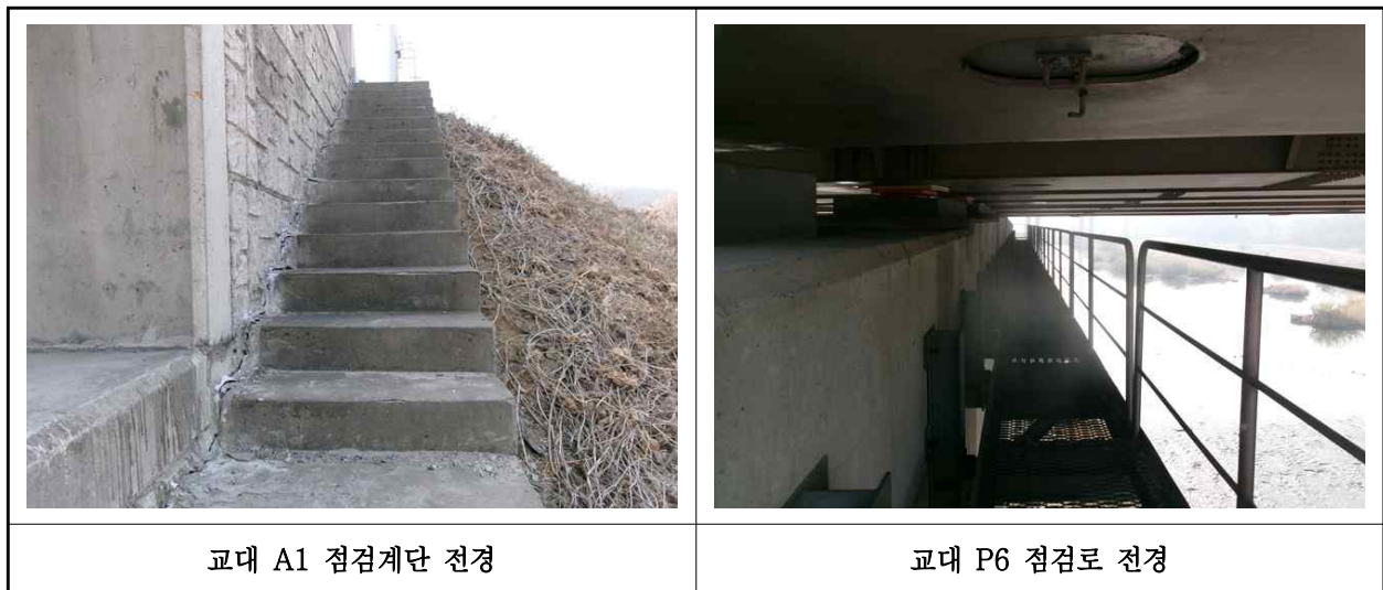
【사진 1.3.25】 교량 점검시설 전경
