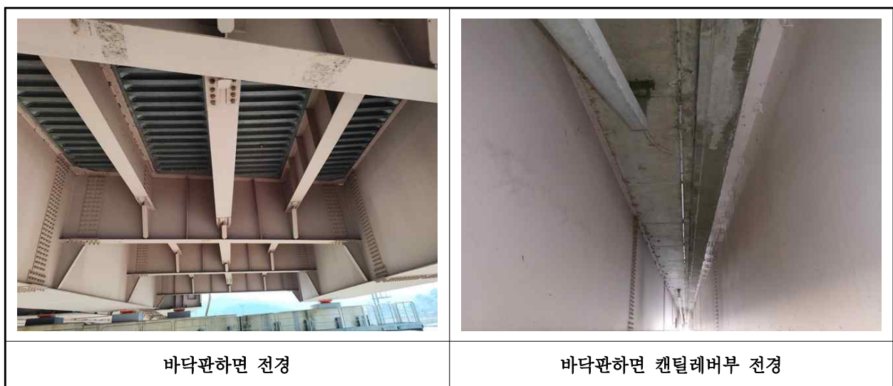
【사진 1.3.2】 바닥판하면 전경
