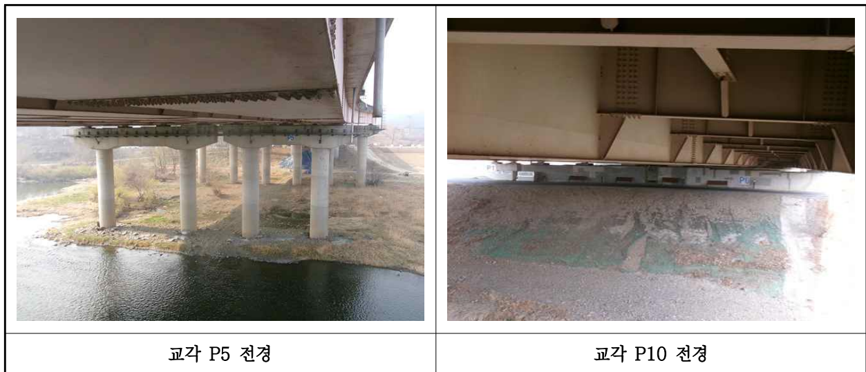
【사진 1.3.10】 교각 전경
