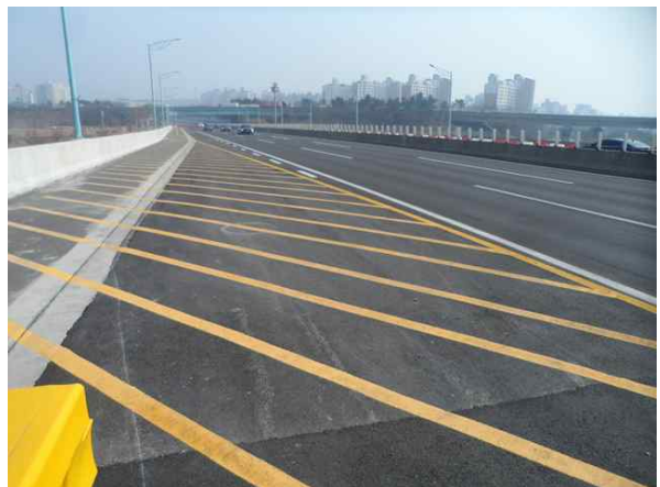
2026년 상부 범물방향 합류부 방호벽 제거구간 현황
