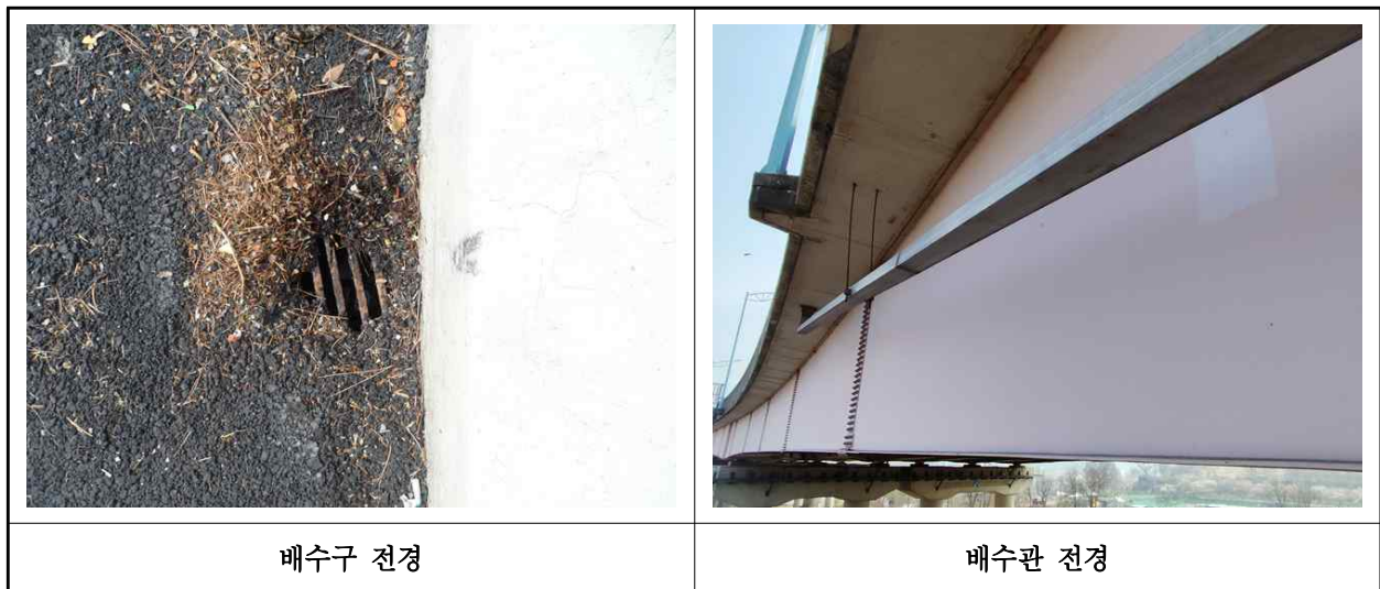
【사진 1.3.21】 배수시설 전경
