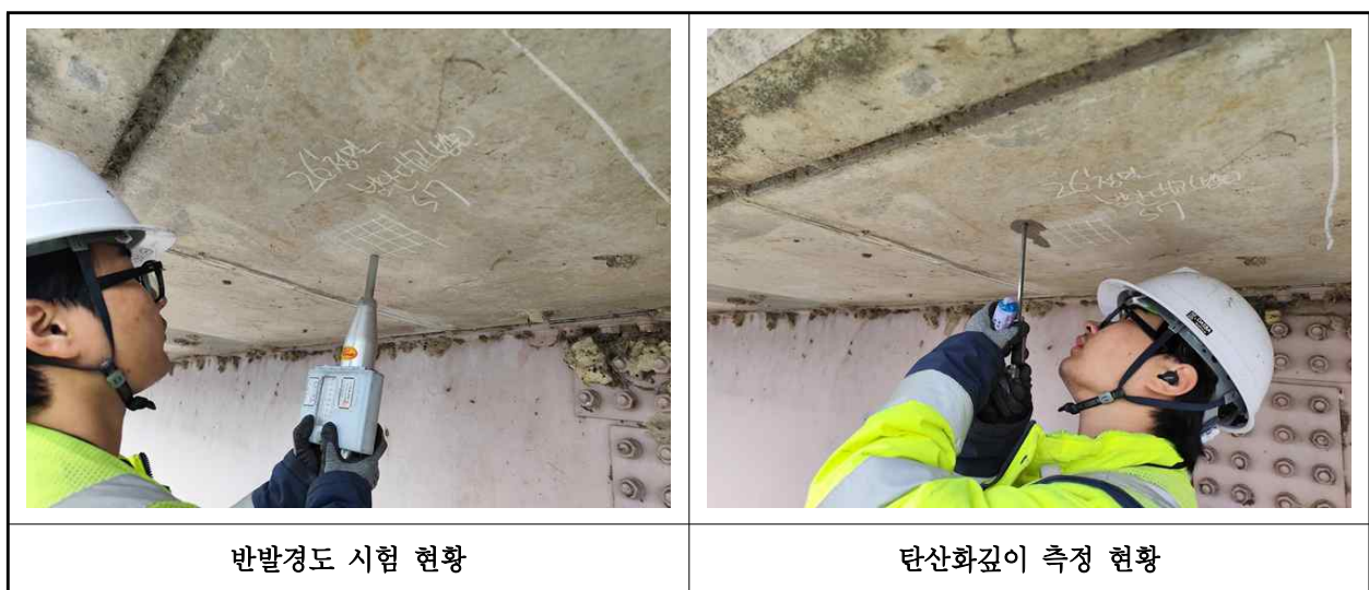
【사진 1.4.1】 콘크리트 내구성조사 현황
