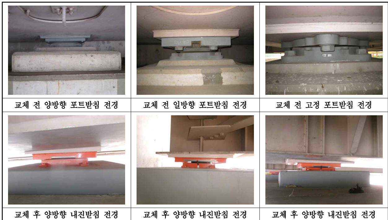
【사진 1.3.12】 교량받침 전경
