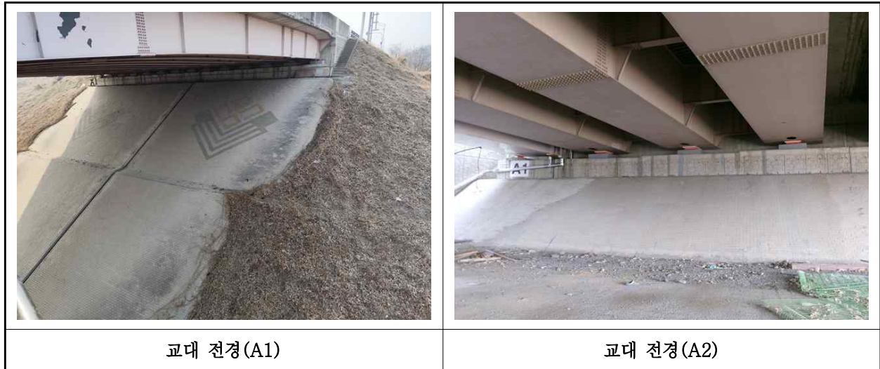
【사진 1.3.8】 교대 전경
