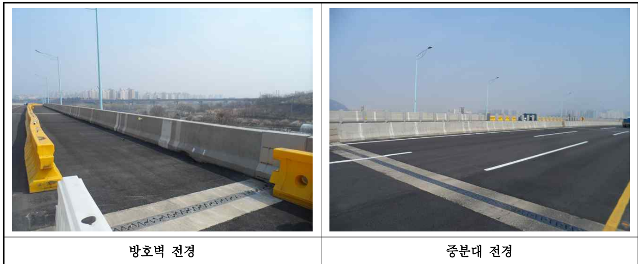
【사진 1.3.50】 방호벽 및 중분대 전경
