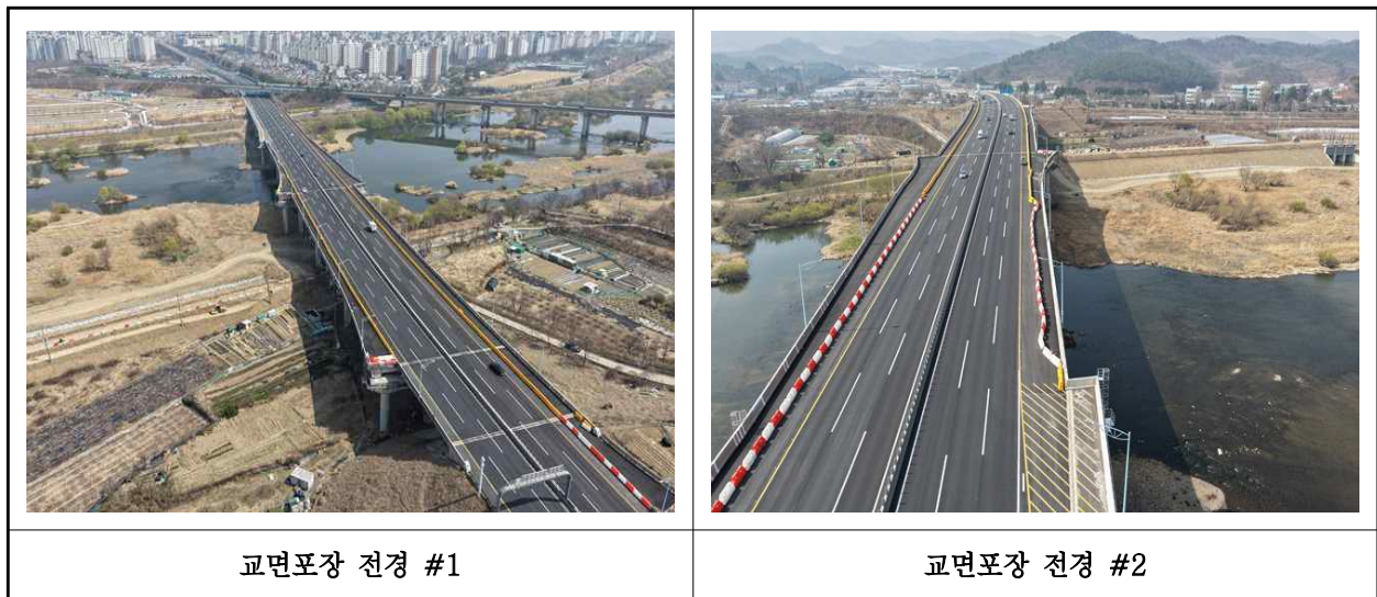
【사진 1.3.19】 교면포장 전경
