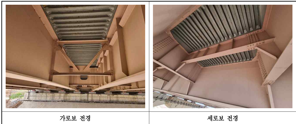
【사진 1.3.32】 가로보 및 세로보 전경
