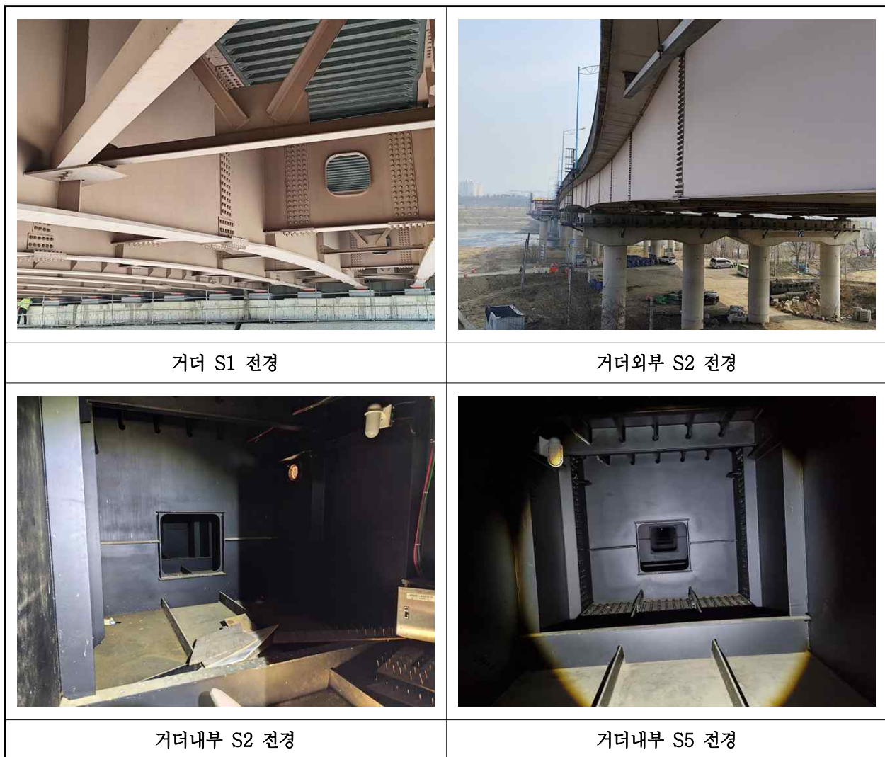
【사진 1.3.4】 거더 전경
