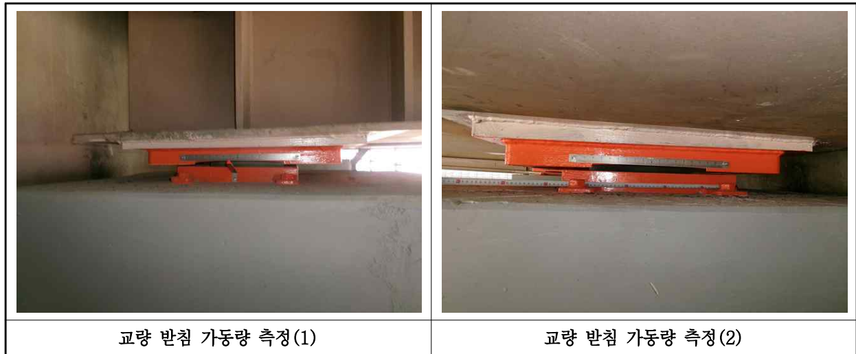
【사진 1.3.42】 교량받침 이동량 측정
