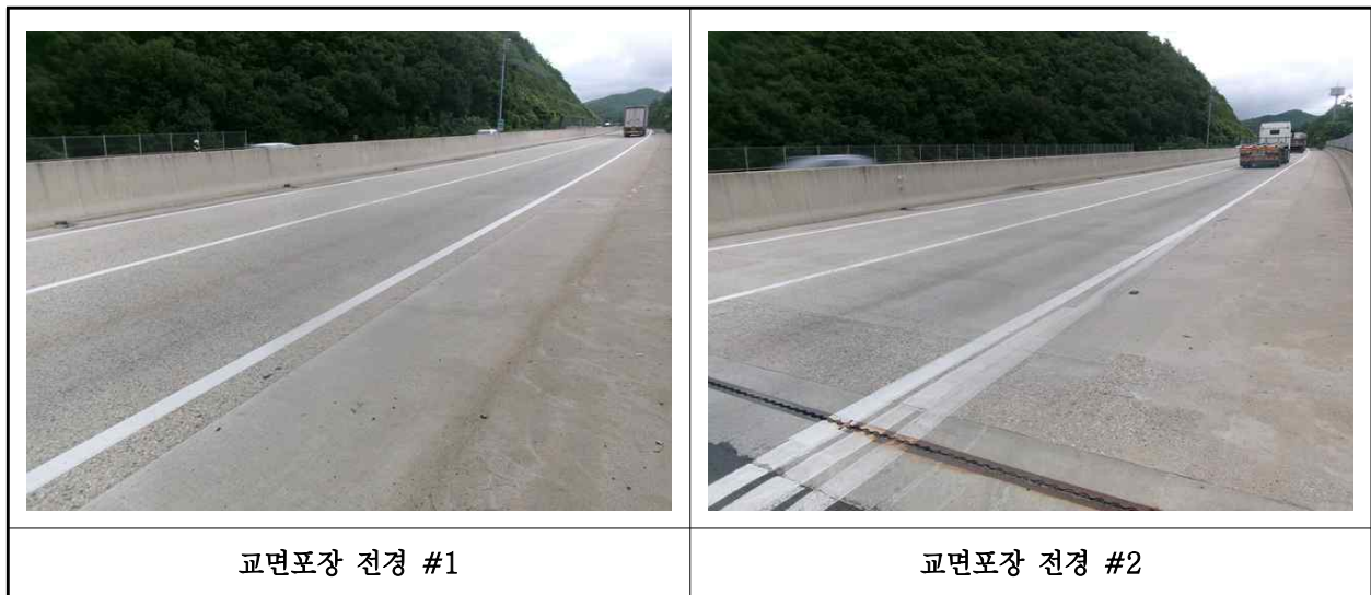
【사진 1.3.46】 교면포장 전경
