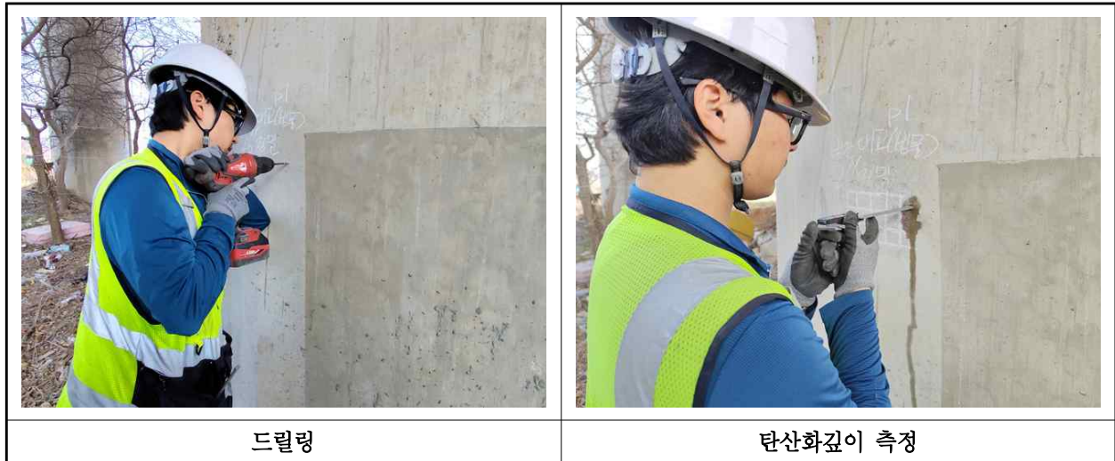
【사진 1.4.3】 탄산화 깊이 측정 현장사진
