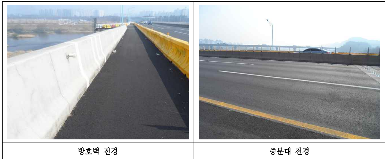
【사진 1.3.23】 방호벽 및 중분대 전경
