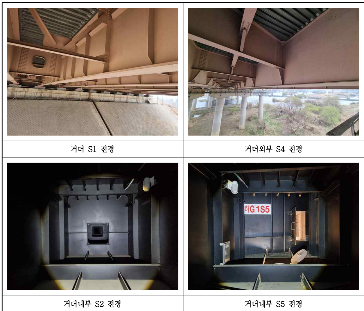
【사진 1.3.30】 거더 전경
