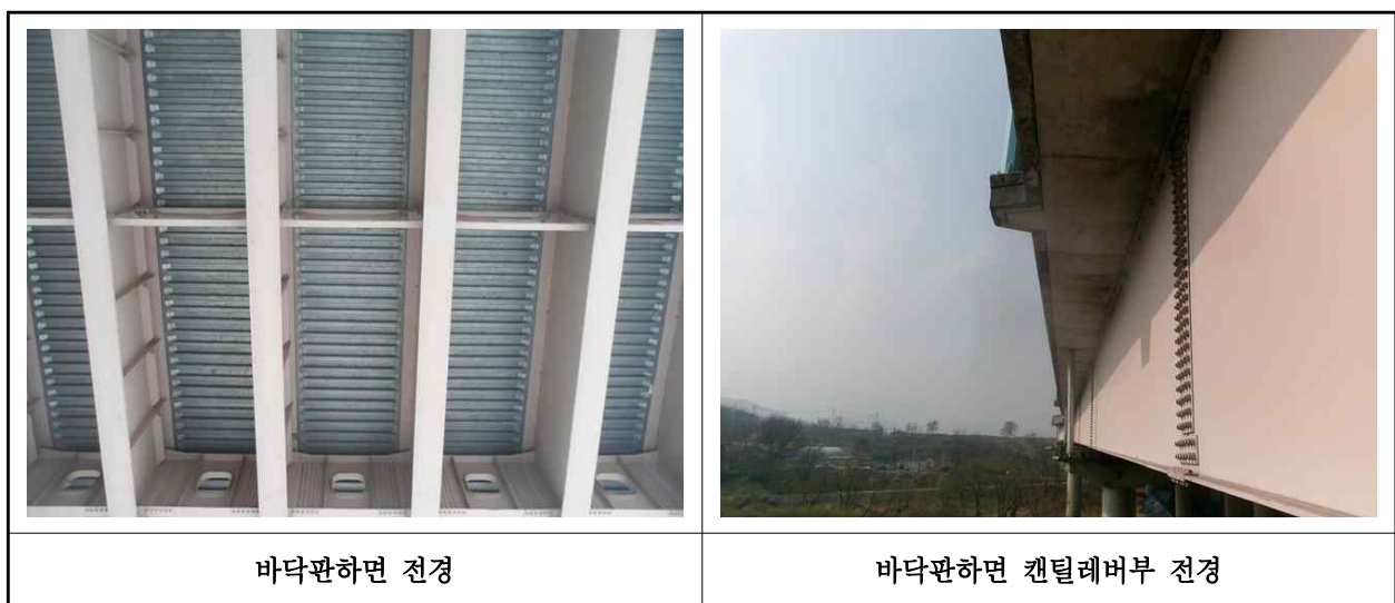
【사진 1.3.28】 바닥판하면 전경
