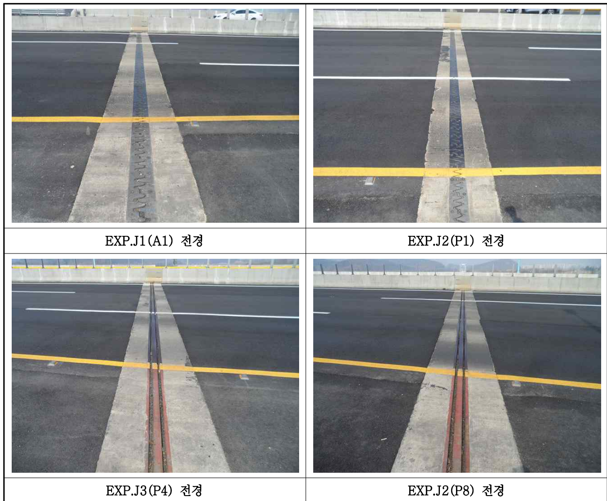
【사진 1.3.43】 신축이음장치 전경
