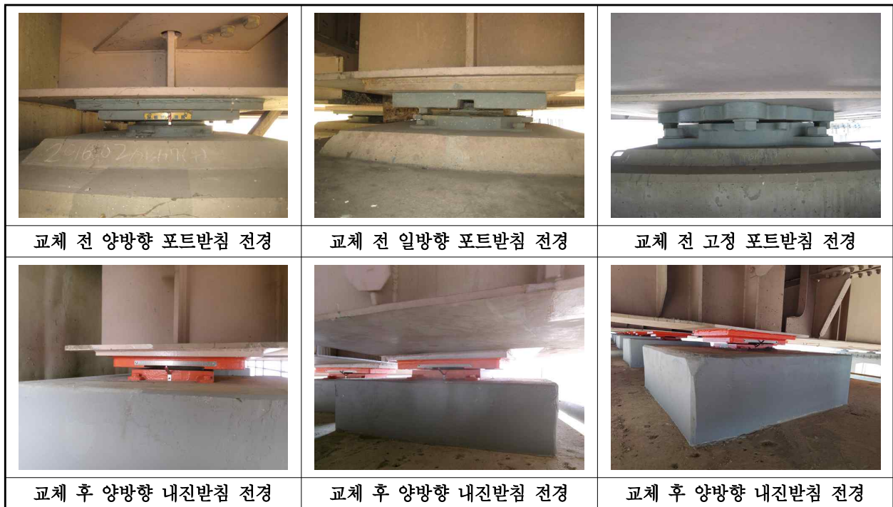
【사진 1.3.39】 교량받침 전경
