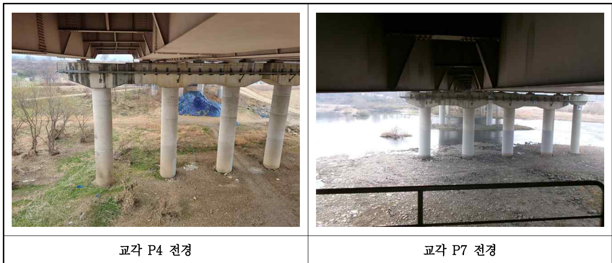
【사진 1.3.36】 교각 전경
