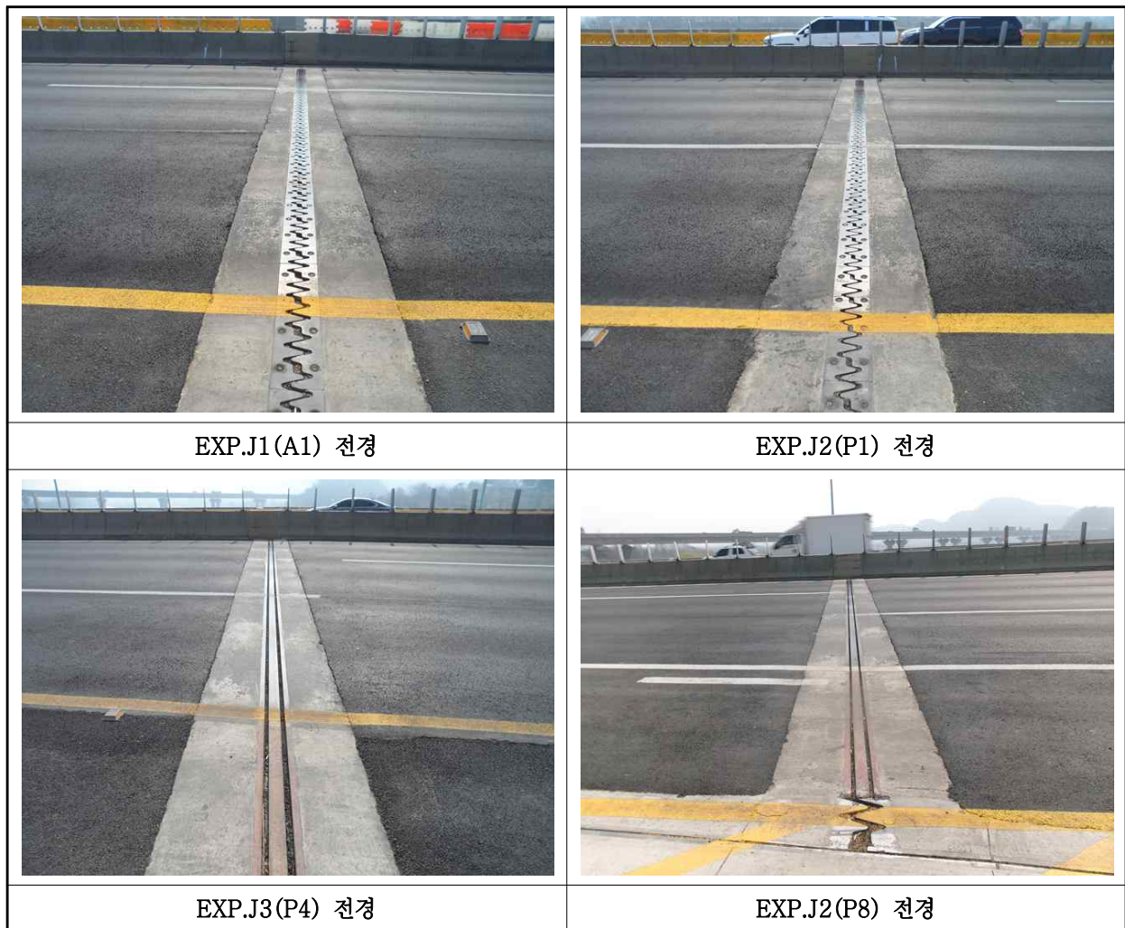
【사진 1.3.16】 신축이음장치 전경
