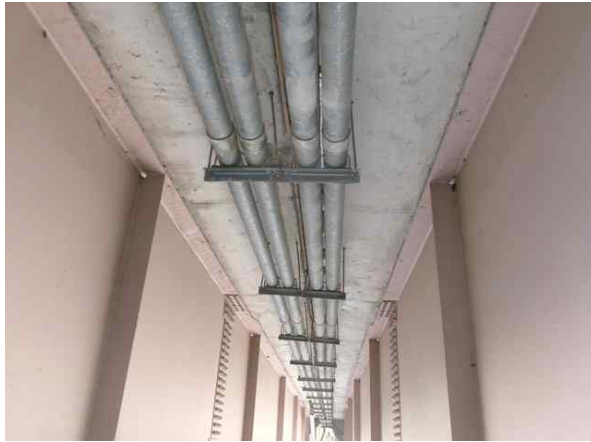
바닥관하면 S1 내측 캔틸레버 상태현황
