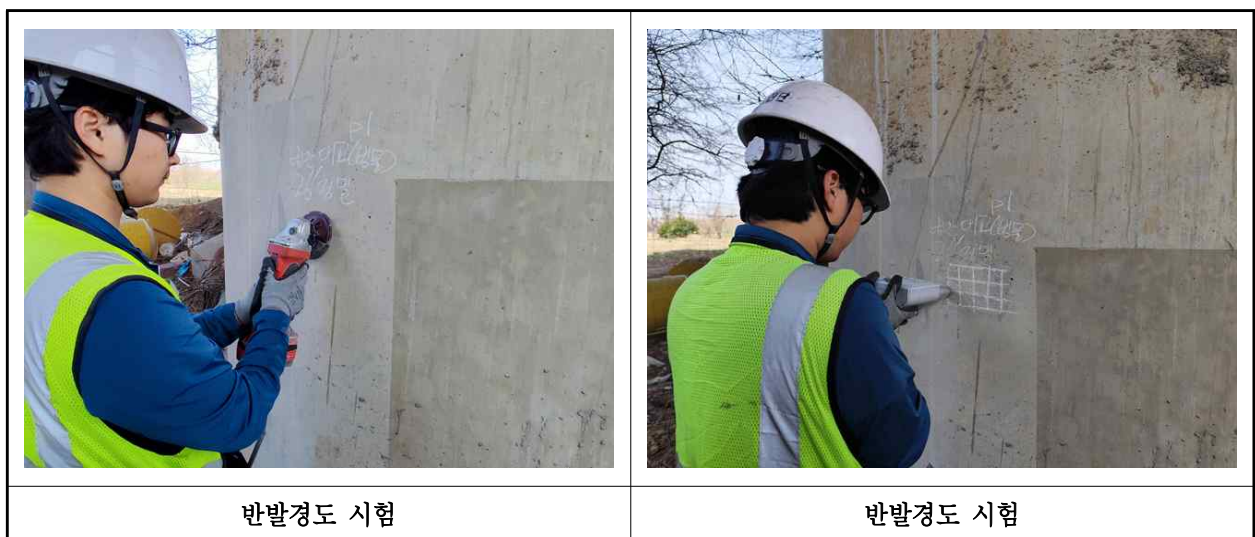
【사진 1.4.2】반발경도시험 현장사진
