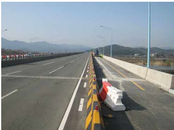
2024년 상부 범물방향 합류부 방호벽 제거구간 현황
