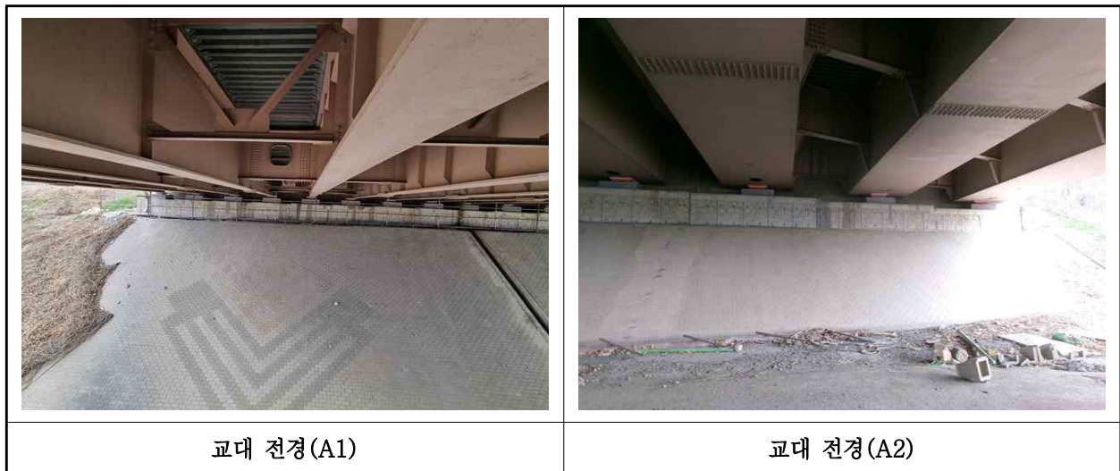
【사진 1.3.34】 교대 전경
