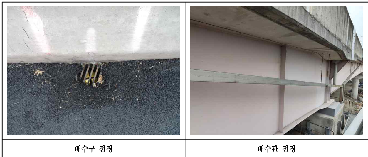
【사진 1.3.48】 배수시설 전경
