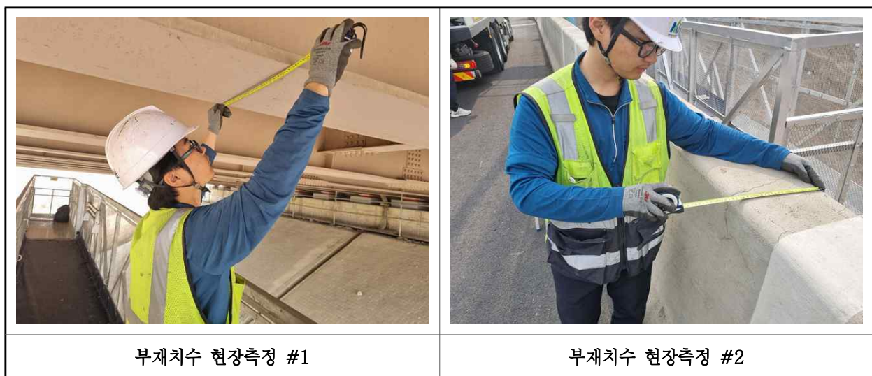
【사진 1.2.1】 부재 현장측정 전경
