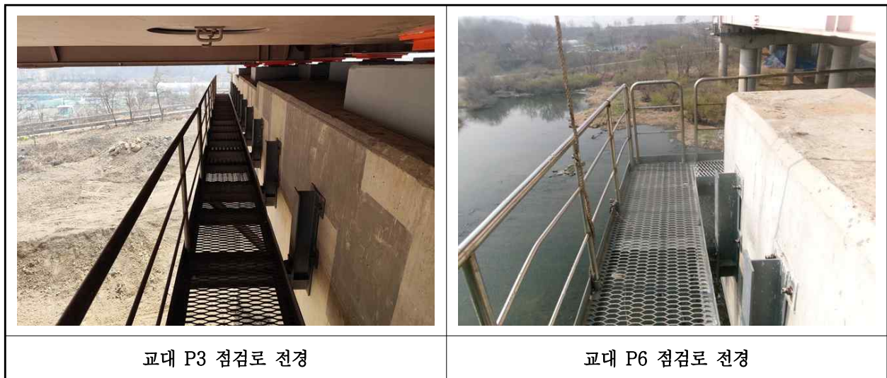
【사진 1.3.52】 교량 점검시설 전경
